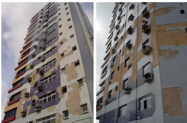
Figura 2: Deslocamento de revestimento cerâmico
