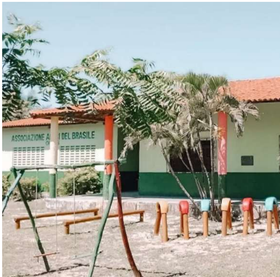
Figura 1 - Unidade Escolar CEM Ferdinando Tansi, em Aquiraz/Ceará
