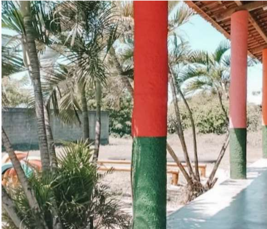
Figura 4 - Unidade Escolar CEM Ferdinando Tansi, em Aquiraz/Ceará
