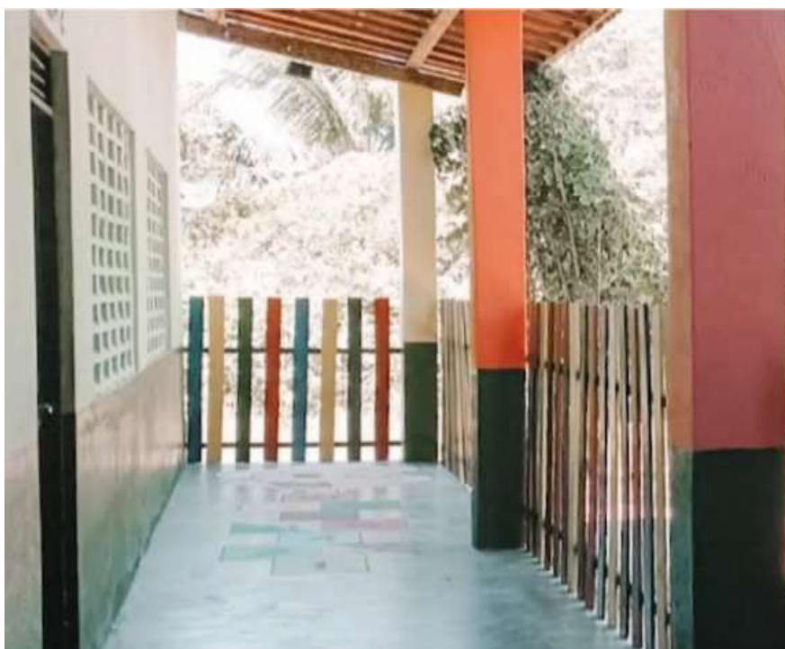
Figura 3 - Unidade Escolar CEM Ferdinando Tansi, em Aquiraz/Ceará
