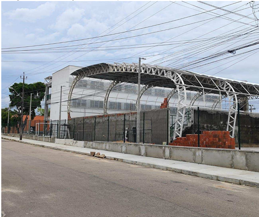
Figura 3: Construção no novo prédio da EEFM Almirante Tamandaré
