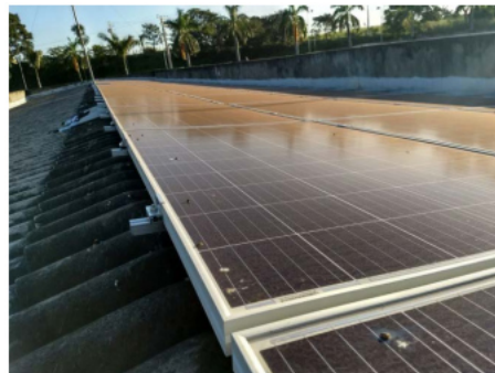
Figura 12 – Sujidade nos módulos.
