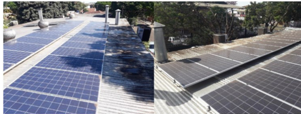
Figura 13 – Sombreamento nos painéis.
