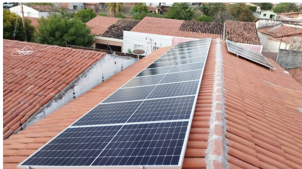
Figura 19 – Sistema fotovoltaico instalado.
