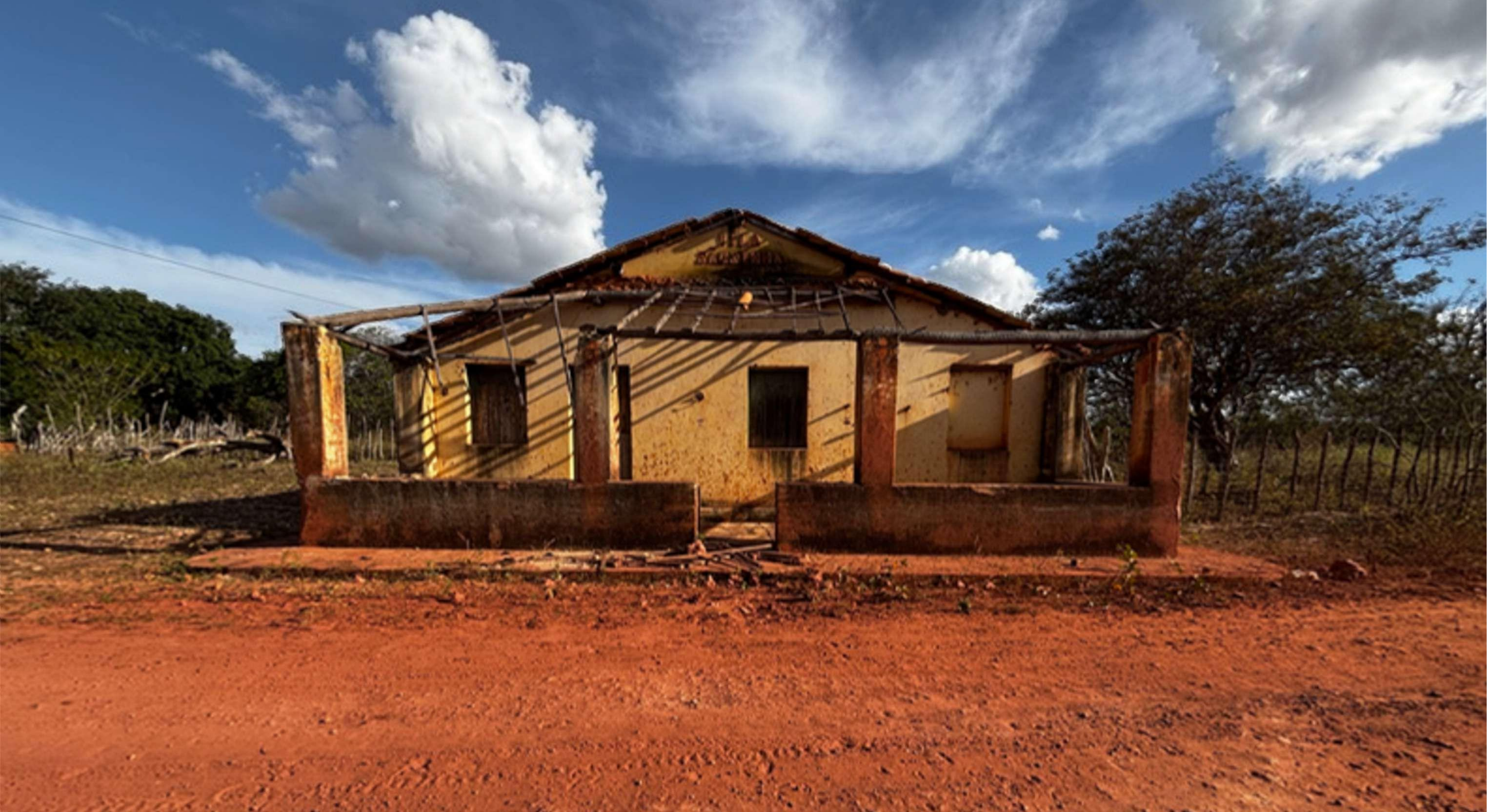
Foto de uma das diversas casas abandonadas das estradas de terra da região.
