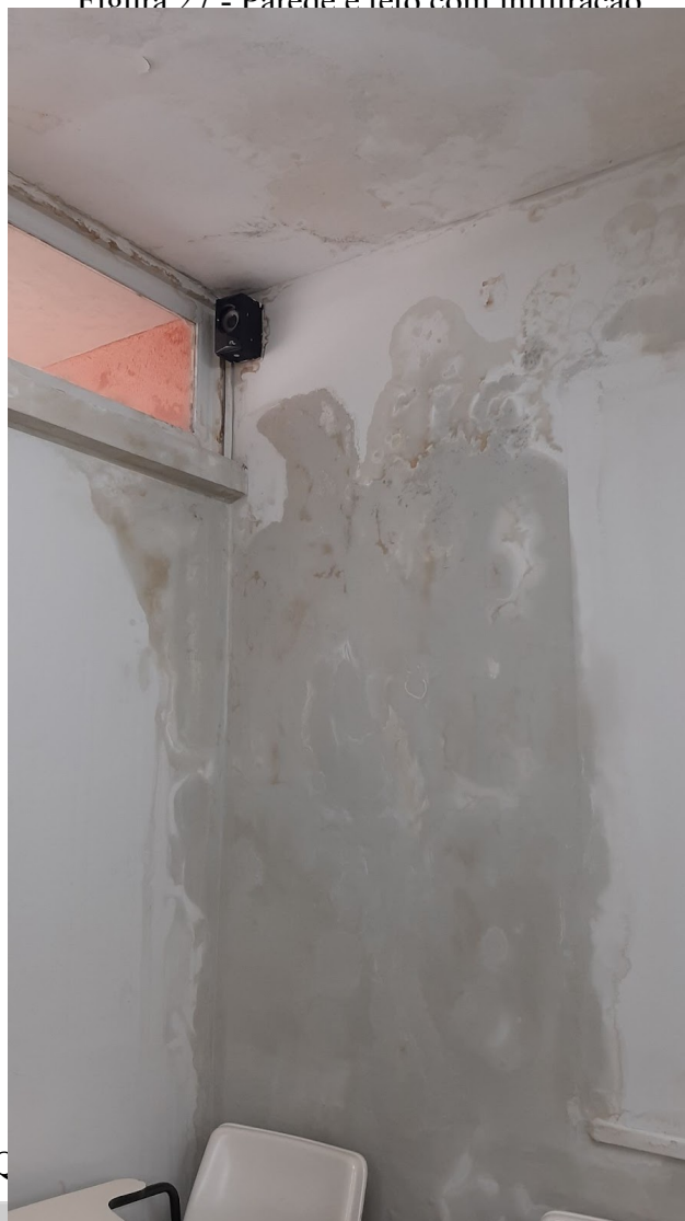
Figura 27 - Parede e teto com infiltração
