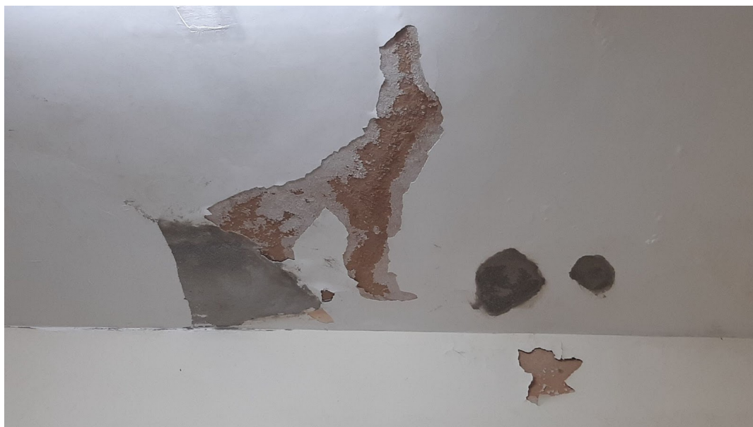
Figura 47 - Destacamento de pintura
