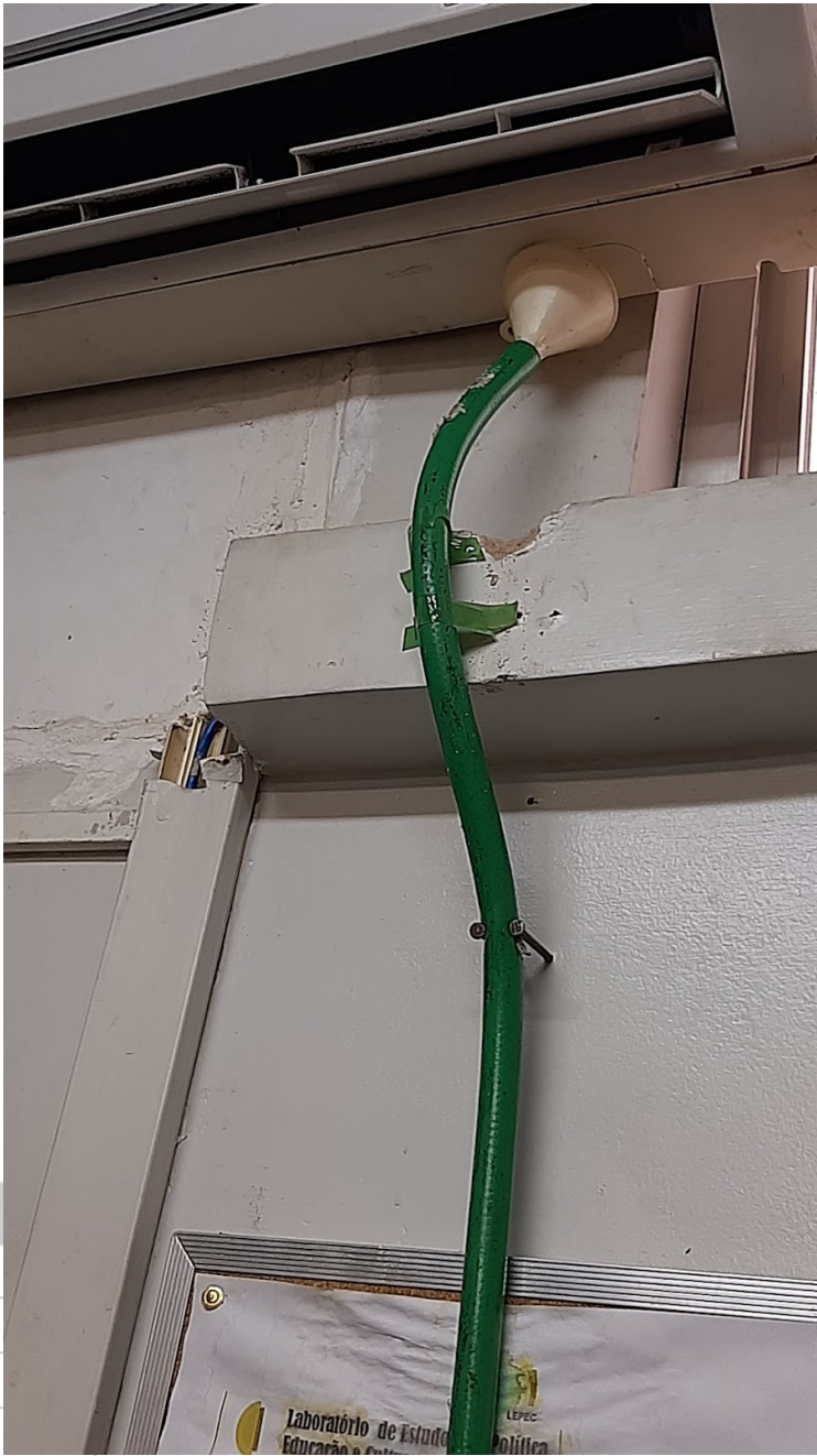
Figura 38 - Instalação inadequada para ar condicionado
