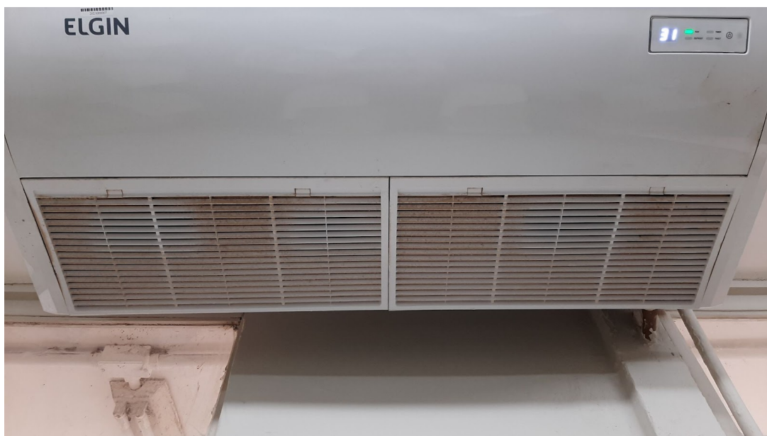
Figura 24 - Ar condicionado com partes oxidadas
