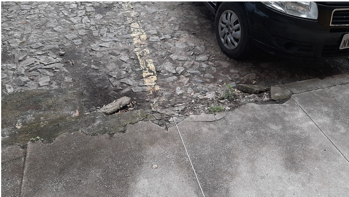
Figura 67 - Passeio quebrado
