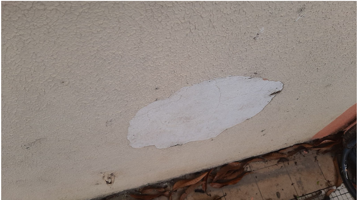
Figura 58 - Destacamento de pintura na fachada
