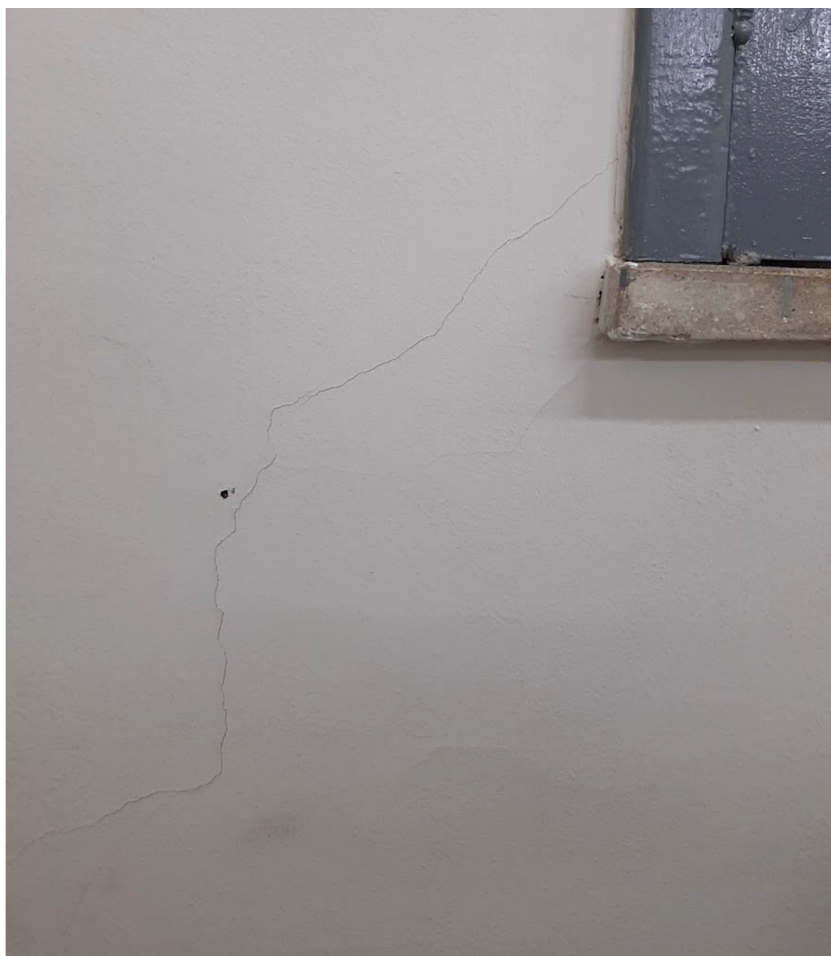
Figura 26 - Fissura na extremidade da janela
