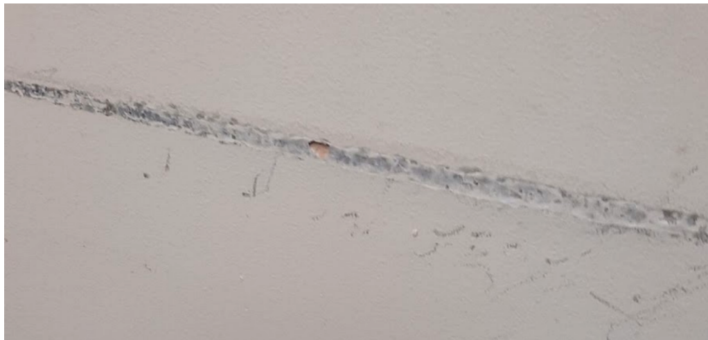
Figura 40 - Parede com manchas provocadas por encostos
