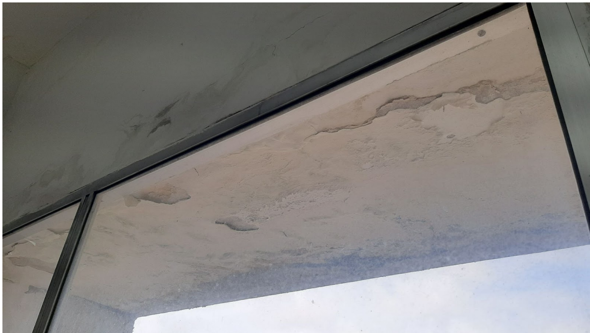
Figura 18 - Infiltrações próximas às janelas
