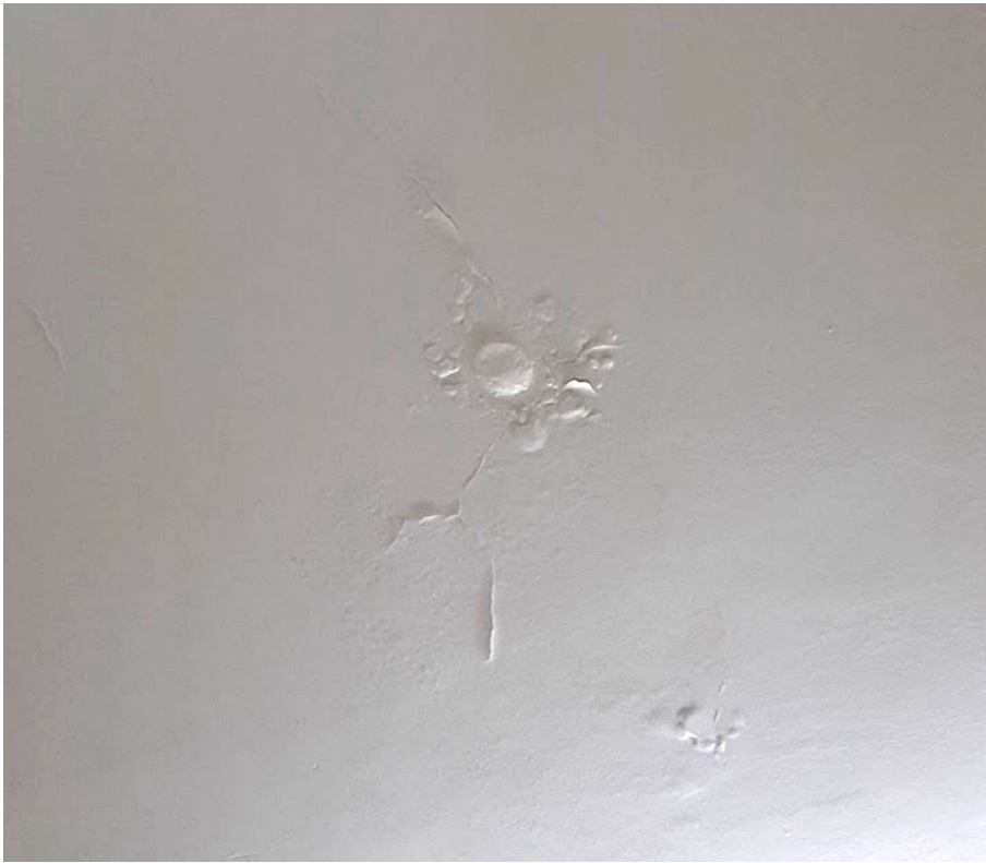
Figura 32 - Bolhas causadas por infiltração
