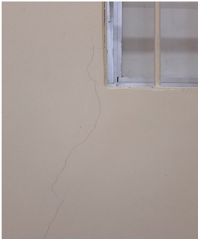
Figura 30 - Parede com fissuras
