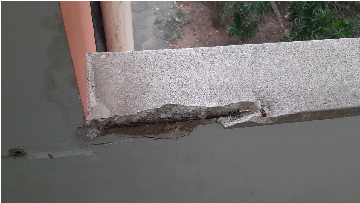
Figura 55 - Armadura exposta em guarda-corpo
