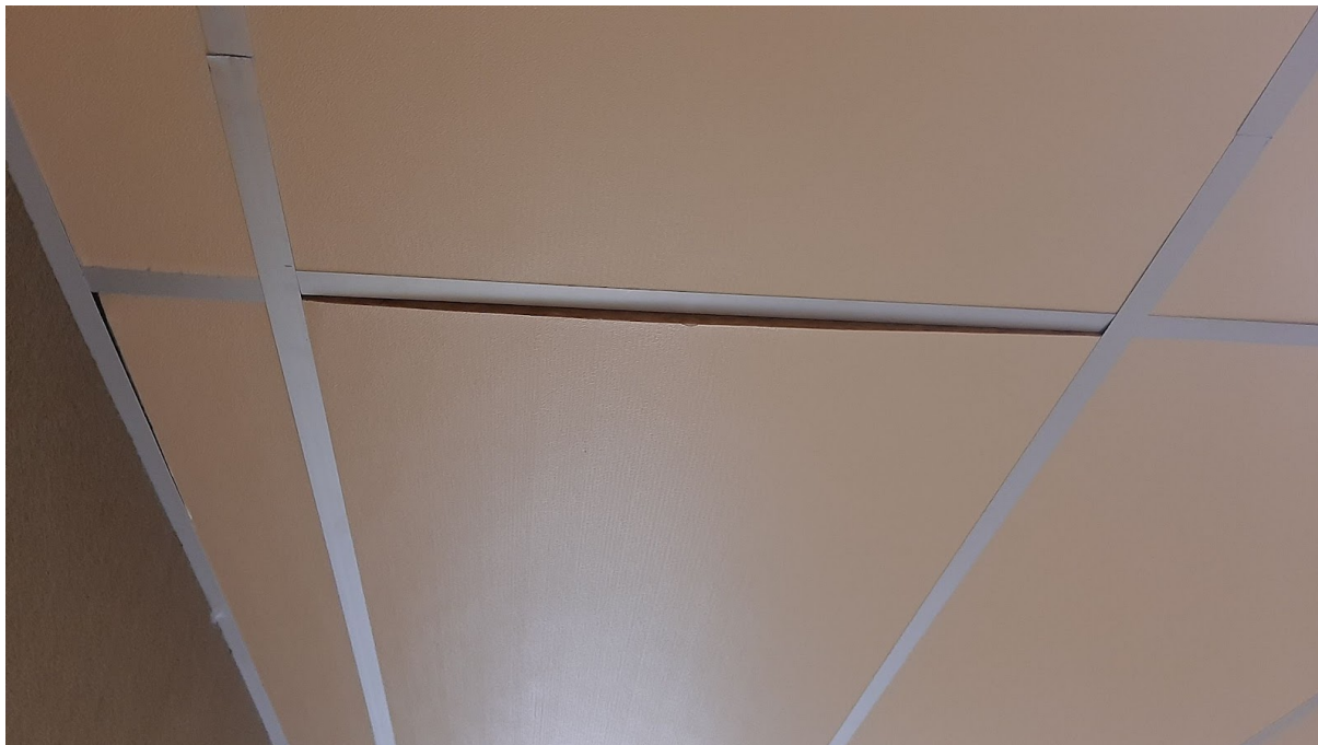
Figura 33 - Forro desencaixado
