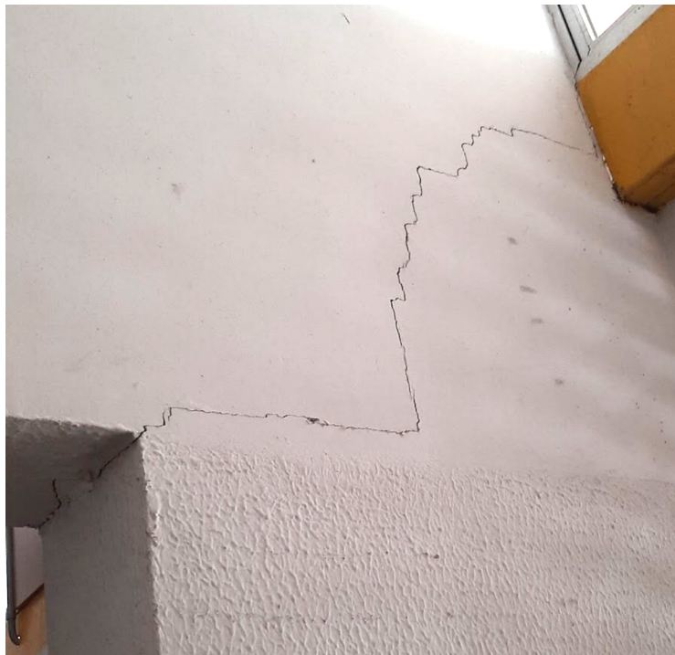
Figura 45 - Trinca na parede do almoxarifado
