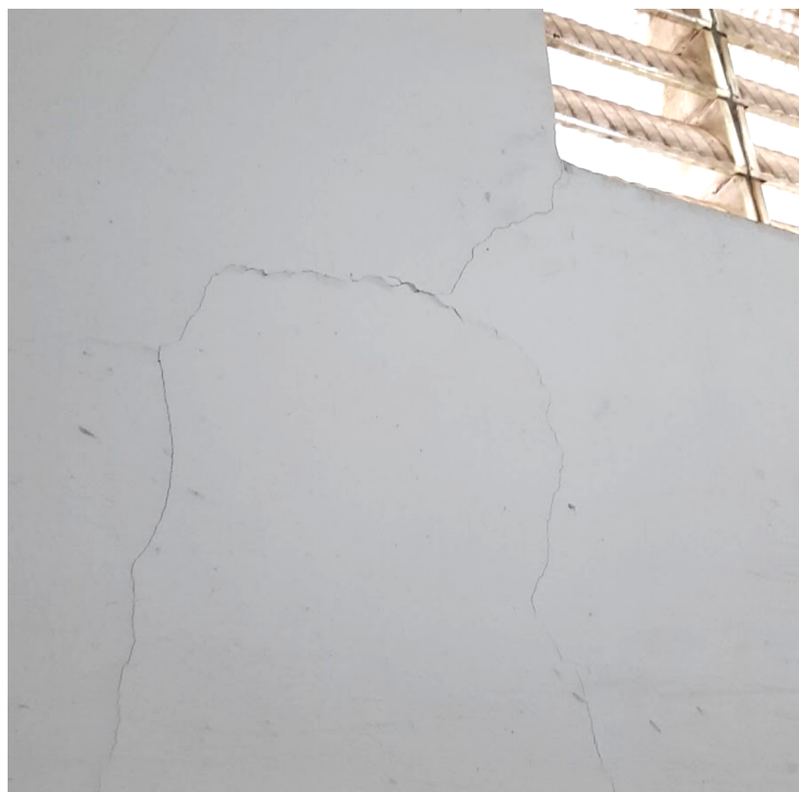
Figura 49 - Parede do banheiro com fissuras
