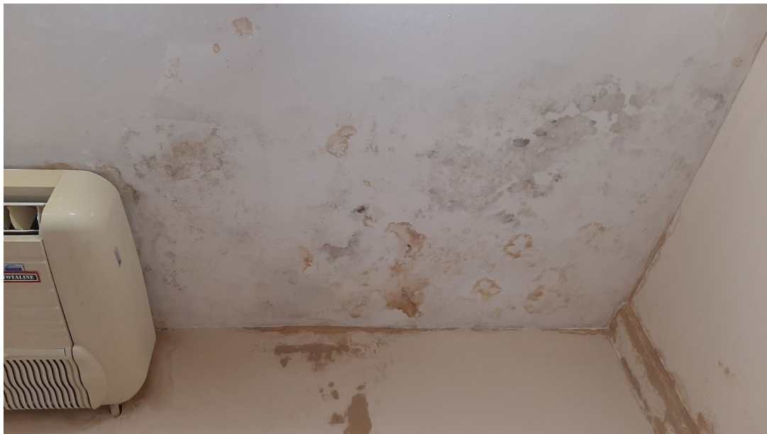
Figura 28 - Teto com infiltração
