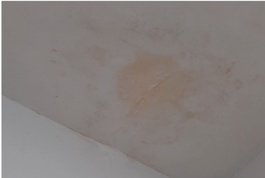
Figura 20 - Mancha no teto causada por infiltração
