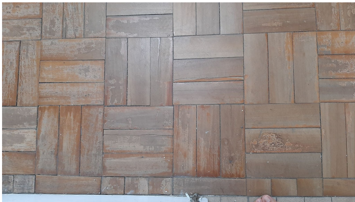
Figura 13 - Piso de madeira desgastado
