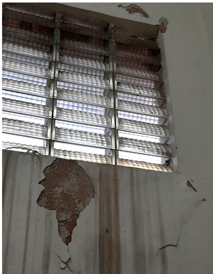
Figura 48 - Parede descascando
