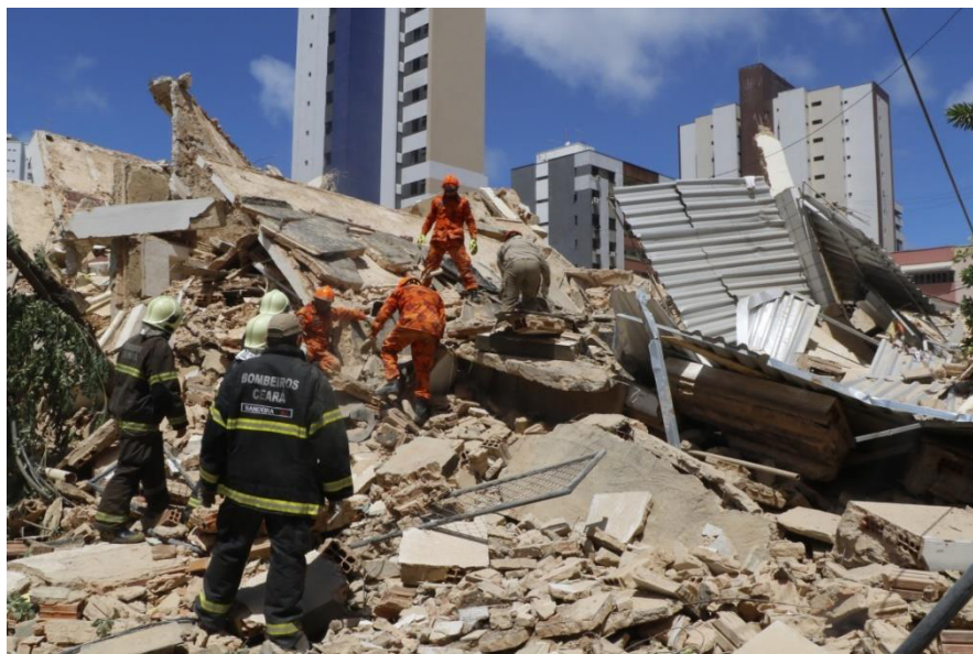
Figura 7 – Ruínas após desabamento do Edifício Andrea em Fortaleza
