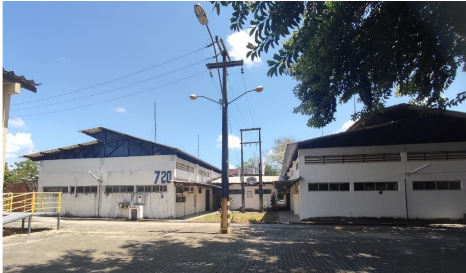
Figura 3 - Fachada do Bloco 720
