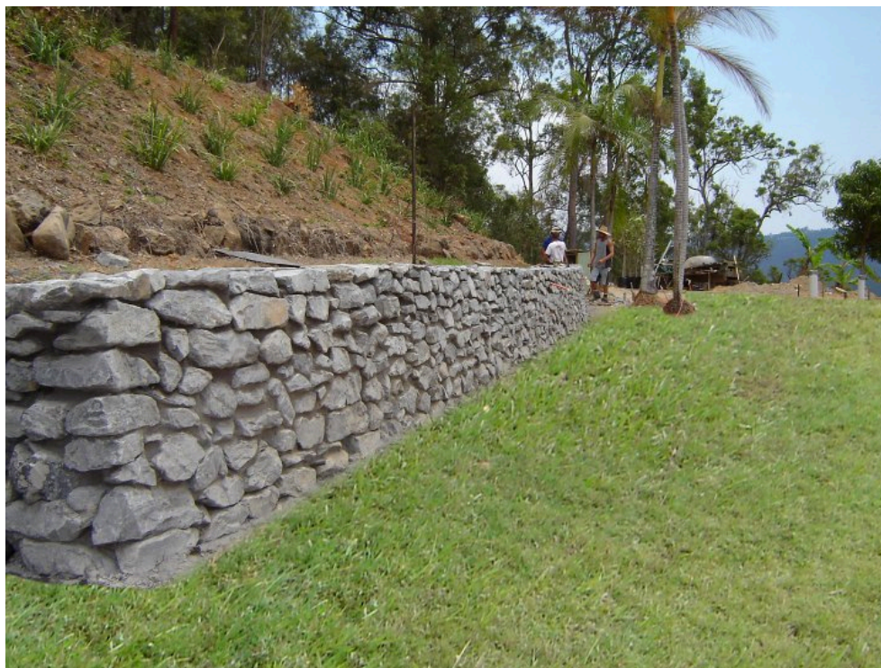
Figura 02 - Muro de gravidade em alvenaria de pedra.
