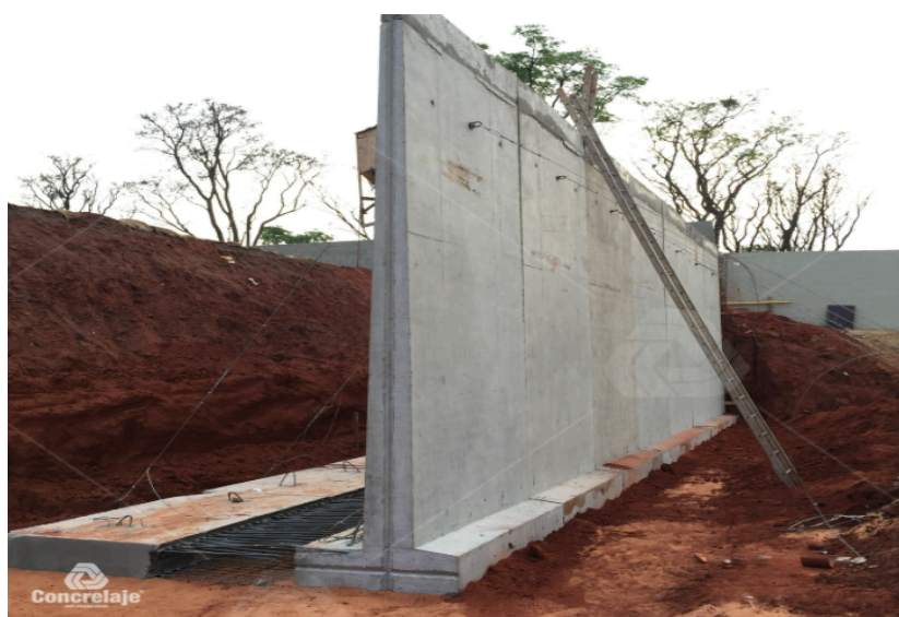
Figura 05 - Execução de muro de flexão em concreto armado.
