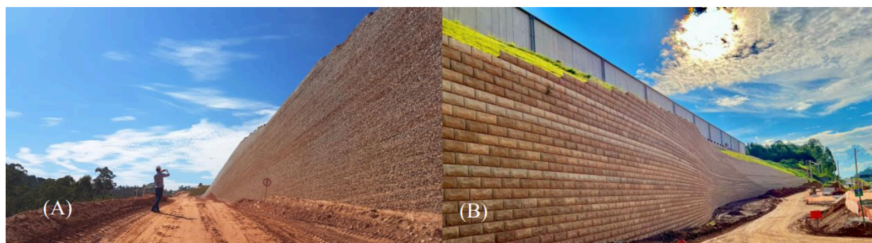
Figura 06 - Estruturas de contenções reforçadas com geogrelhas na cidade de Cajamar SP em 2021.
