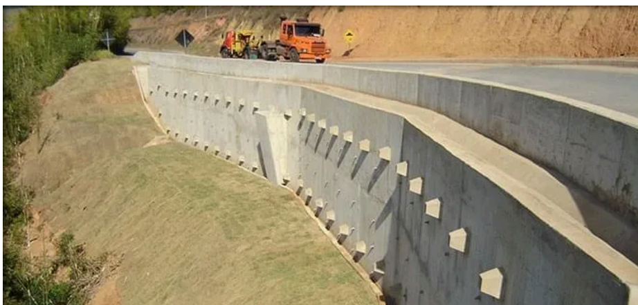
Figura 09 - Cortina atirantada contendo encosta em estrada
