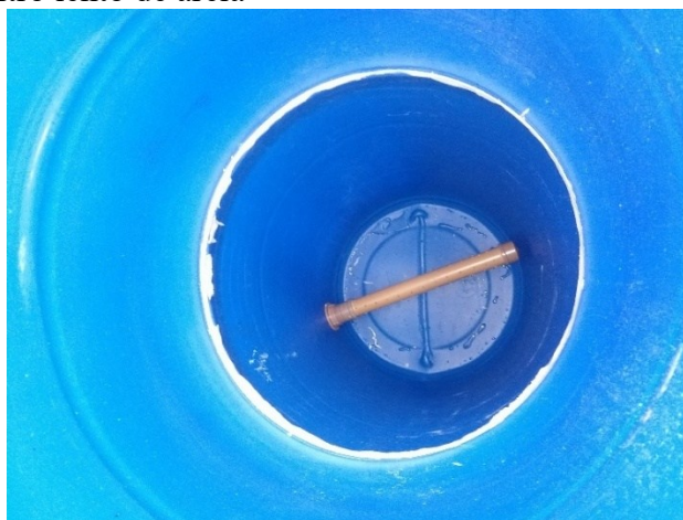
Figura 2 – Tubo de drenagem instalado no fundo do filtro lento de areia
