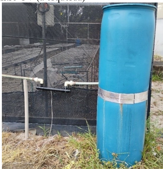
Figura 1 – Sistema de desinfestação formado pelo filtro lento de areia (à direita) e filtro UV (à esquerda)
