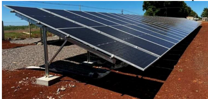
Figura 3 – Exemplo de módulos fotovoltaicos instalados ao solo em perfis fixos.
