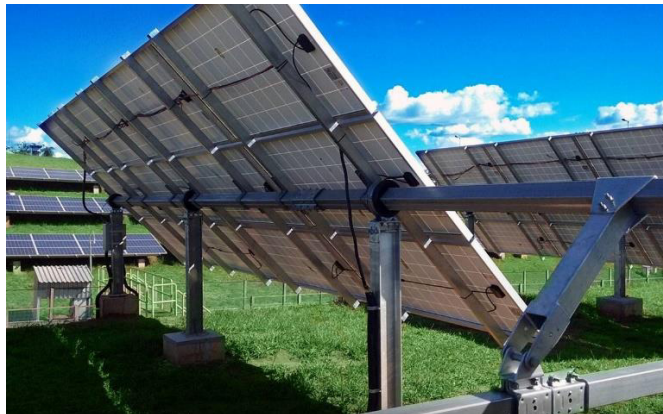
Figura 4 – Exemplo de módulos fotovoltaicos instalados ao solo em trackers .
