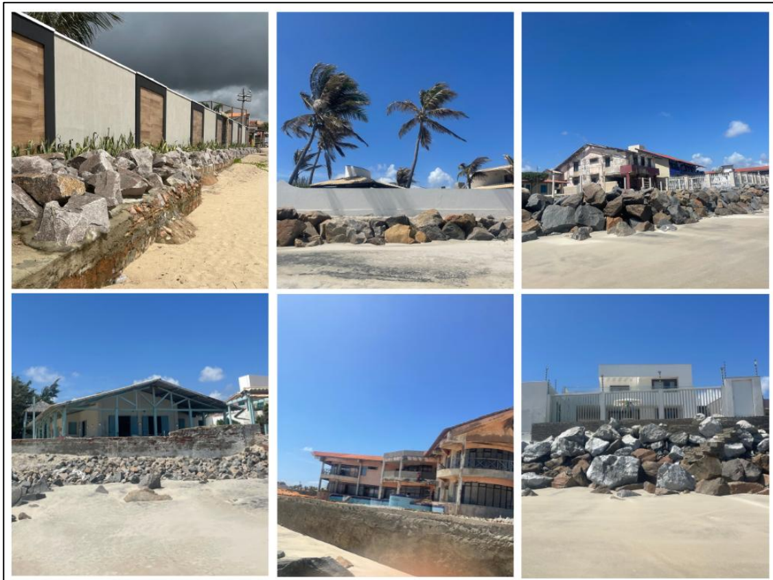
Figura 11- Imagens de estruturas para conter a erosão na praia da Caponga.
