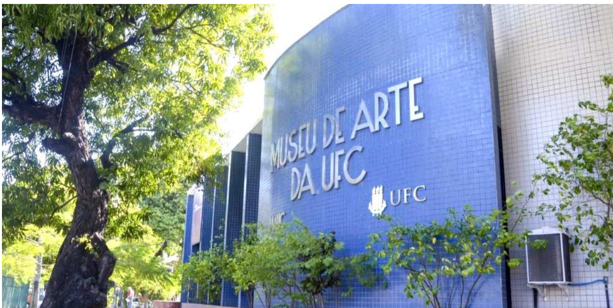
Figura 1 - Atual Fachada do Museu de Arte da UFC
