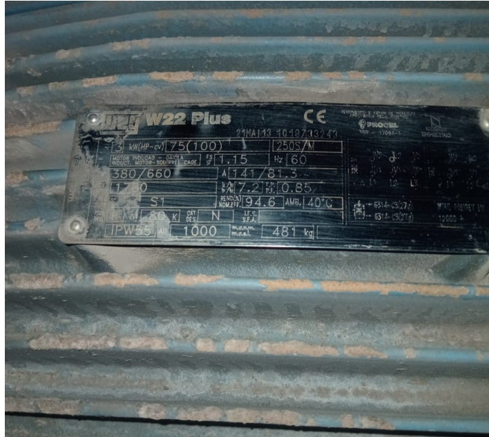
Figura 14 – Levantamento de cargas - dados de placa do motor 8
