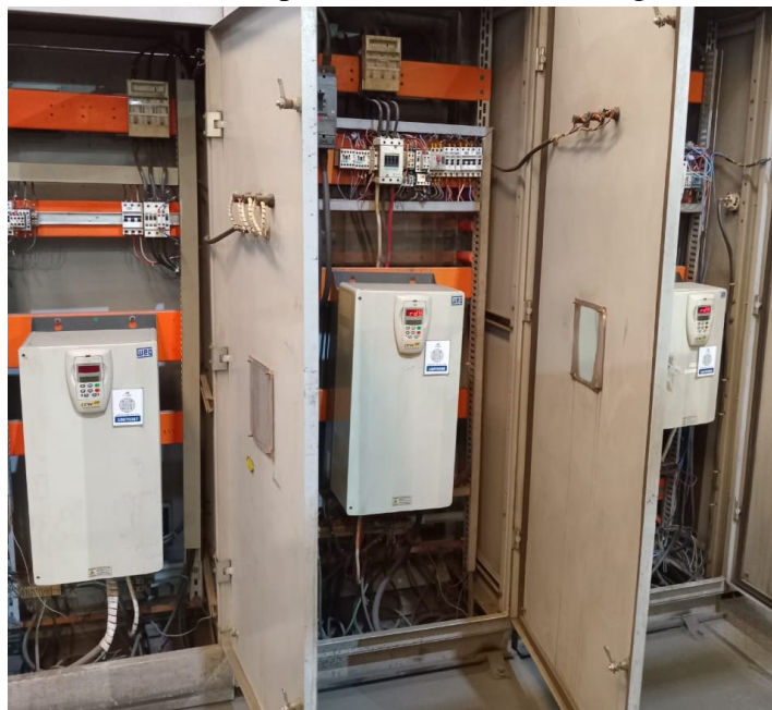
Figura 15 – Inversores para acionamento das cargas
