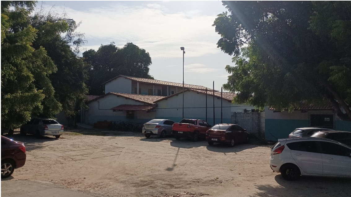
Imagem 2 - Garagem da Escola Casimiro Montenegro (11/02/2025)
