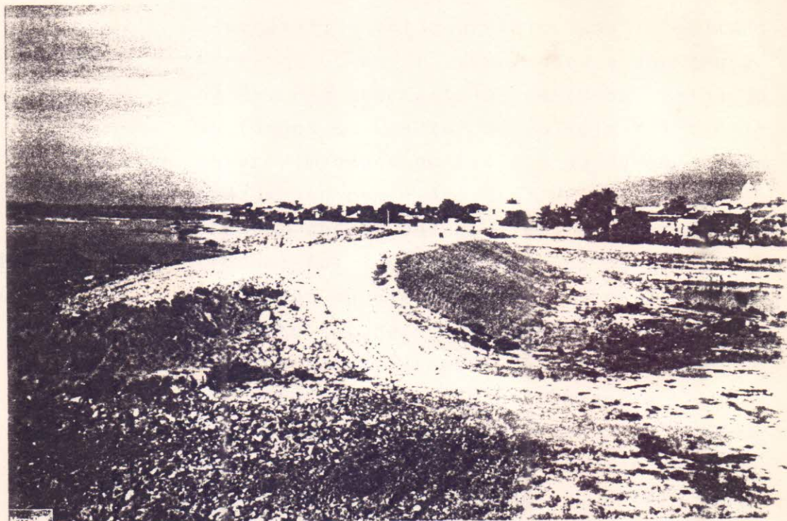
Av. Beira-Rio em construção
