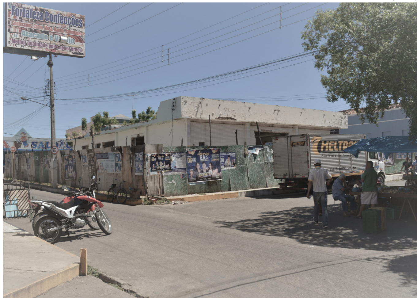
O antigo prédio do BEC teve sua arquitetura original alterada e se encontra em estado de deterioração - outubro de 2016 [autora]
