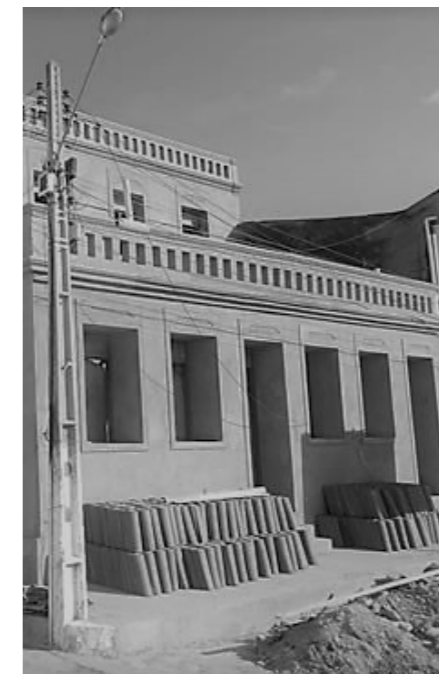
Atualmente, a casa se encontra em fase final de restauração [ http://www.miseria.com.br/?page=noticia&cod_not=177459 ]
