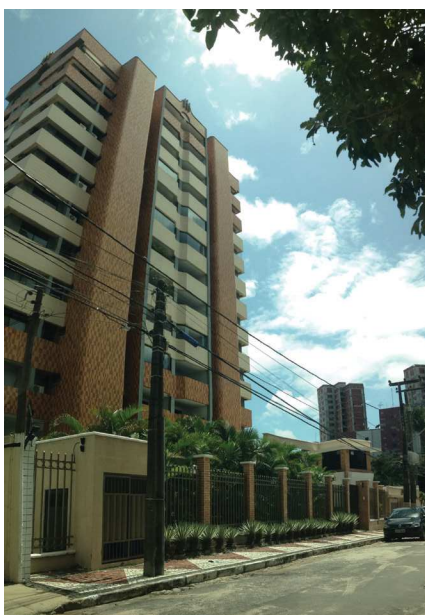
◀ IMAGEM 26. Edifício residencial multifamiliar. Foto: arquivo pessoal
