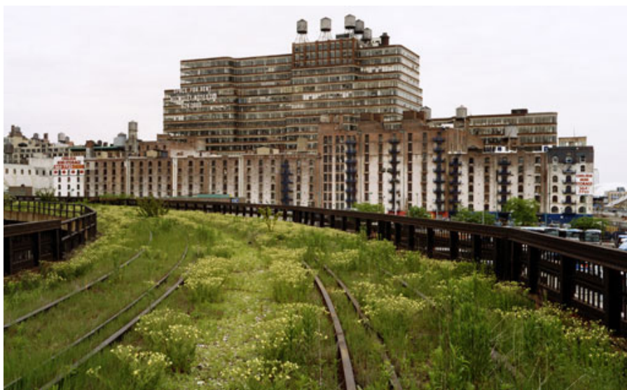
Fig. 4.1C e 4.1D - Imagem da linha férrea antes e durante a construção. Enquanto este ve desativada, a vegetação nativa floresceu naturalmente, conferido uma atmosfera selvagem em contrapartida com o ambiente urbano; Imagem da linha férrea sendo preparada para receber a estrutura do parque. Fonte: < http://www.thehighline.org > 25.05.2012
