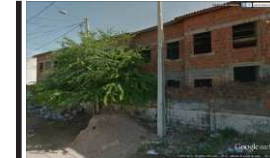
Conjuntos habitacionais inacabados.
