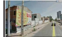
Rua Dr. Francisco Matos. Conjuntos habitacionais inacabados.
