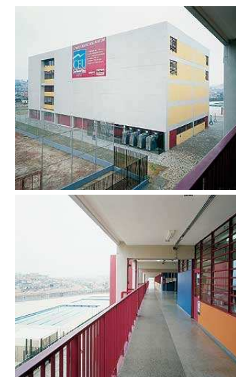
figura 4.13.- Bloco cultural e corredor das salas de aula, CEU Jambreiro, São Paulo.
