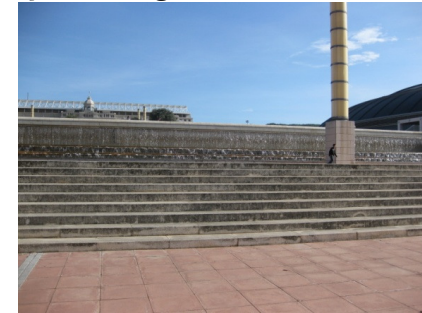
Fig. 24: Parque Montjuïc, Barcelona-EspanhaFonte: foto do autor,2009
