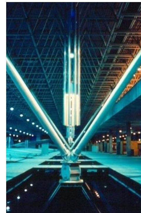
Fig. 14 – Espaço Cultural da Paraíba. Os longos espelhos d’água fazem a separação entre o interior e o exterior do edifício, e 5 grandes tubos que se encerram a 3 metros de altura do chão conduzem as águas da cobertura para estes canais, promovendo um efeito de cascata em dias de chuva. Fonte: http://www.vitruvius.com.br/revistas/read/arquitextos/07.084/248
