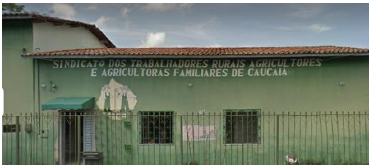
Figura 10: Sede do Sindicato dos Trabalhadores Rurais de Caucaia
