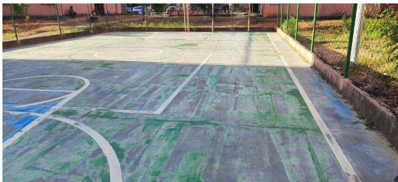
Figura 31 - Quadra do Condomínio Luiz Gonzaga antes da ação de revitalização feita pelo GSC em parceria com a comunidade
