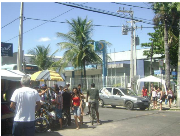
Fig. 97 – Edifício do Instituto Nacional de Seguro Social ( INSS).
