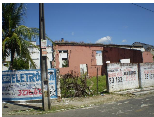
Fig. 119 – Terreno do antigo cine São Luiz, terreno utilizado para construção do novo CUCA Messejana. Fonte: Acervo.
