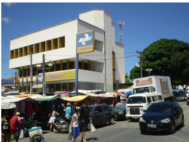
Fig. 95 – Edifício dos Correios cercado por feirantes aos domingos. Fonte: Acervo.
