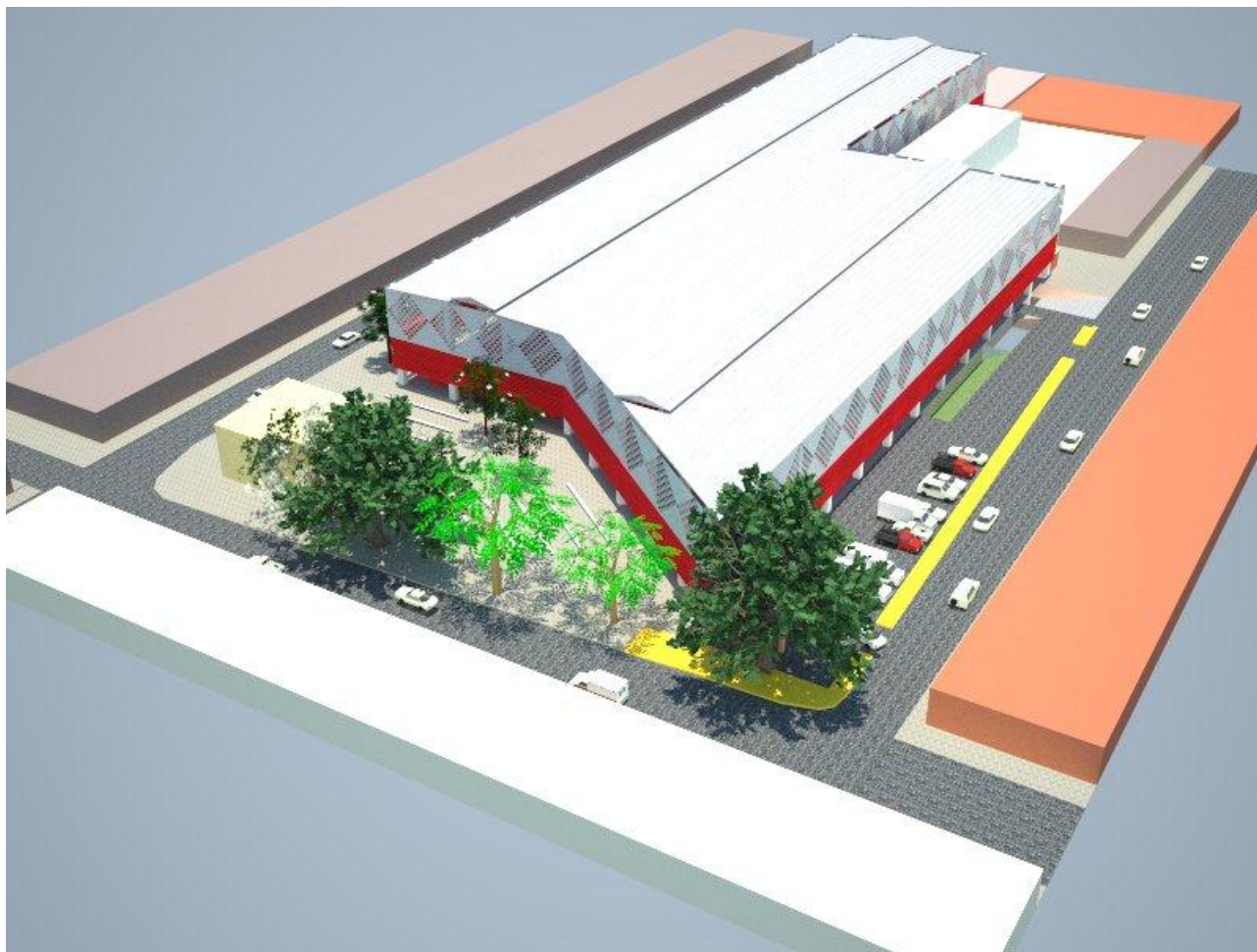
Fig. 155 – Perspectiva geral externa do edifício.
