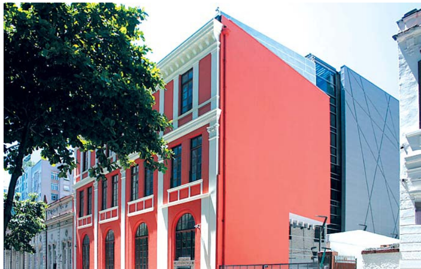
Fig. 6 – Fachada principal do Oi Futuro do Flamengo, no Rio de Janeiro
