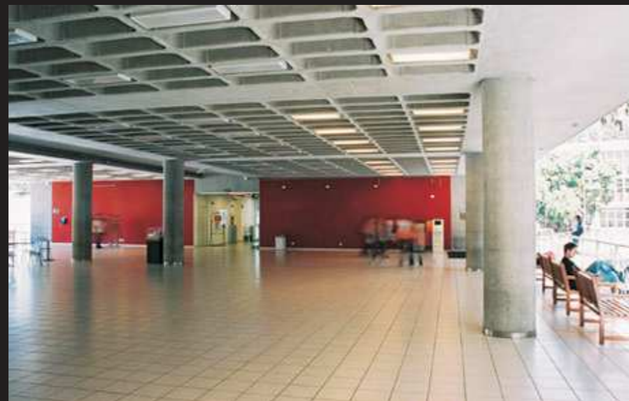
LAJE NERVURADA APARENTE
