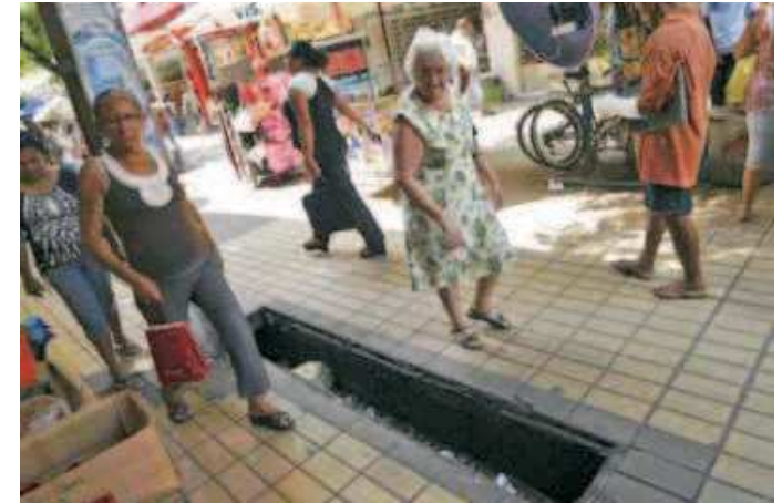
Foto 6 - Caixa de inspeção (tampa retirada).
