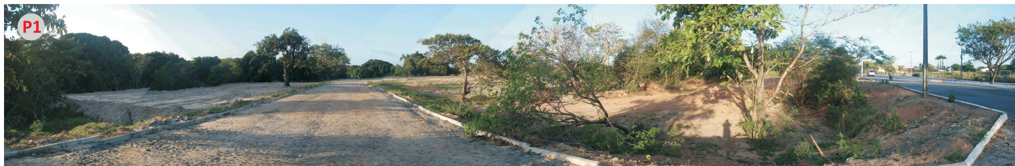
P1 - Panorâmica do terreno / Processo de terraplanagem
