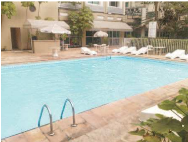
Foto 29 - Piscina sem acessibilidade adequada.
