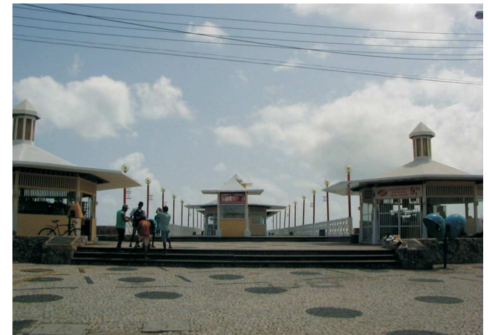
Foto 7 - Acesso a Ponte dos Ingleses apenas por escadas.
