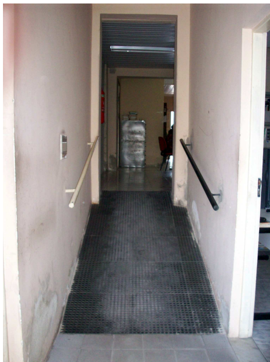
Figura 9 - Rampa de grande inclinação para o acesso ao setor infantil, na Biblioteca Municipal Dolor Barreiras: inacessibilidade da edificação.
