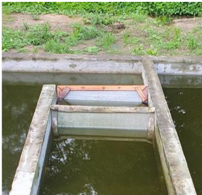
Figura 16 – Tela filtrante do filtro mecânico de um sistema de tratamento de água de um sistema aquapônico destinado a produção de tilápia do Nilo ( Oreochromis niloticus ) e alface ( Lactuca sativa ).
