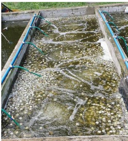
Figura 27 – Mídias biológicas fluidizando no reator biológico devido a ação da aeração de fundo.
