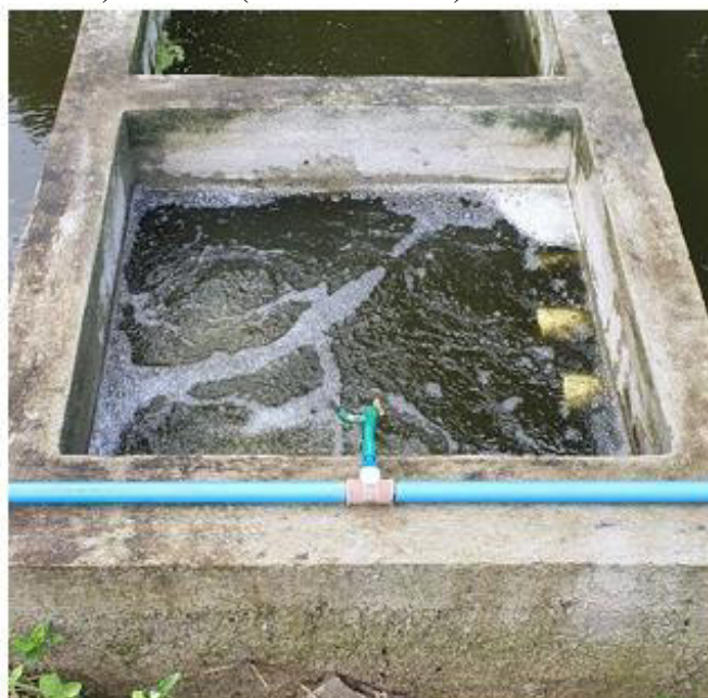
Figura 17 – Espumador construído no final da última câmara da filtragem mecânica de um sistema de tratamento de água de um sistema aquapônico destinado a produção de tilápia do Nilo ( Oreochromis niloticus ) e alface ( Lactuca sativa ).
