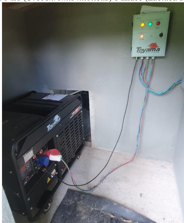
Figura 35 – Sistema de back-up em funcionamento, utilizado em sistema aquapônico para produção de tilápia do Nilo ( Oreochromis niloticus ) e alface ( Lactuca sativa ).
