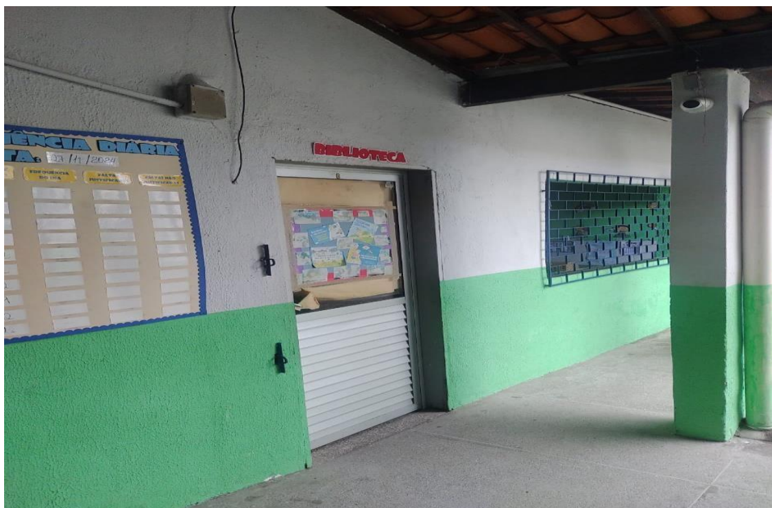
Figura 19 – Porta de acesso para a biblioteca BIB5 (Anexo)
