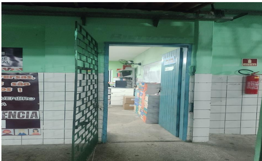
Figura 16 – Porta de acesso para a biblioteca BIB5 (Patrimonial)
