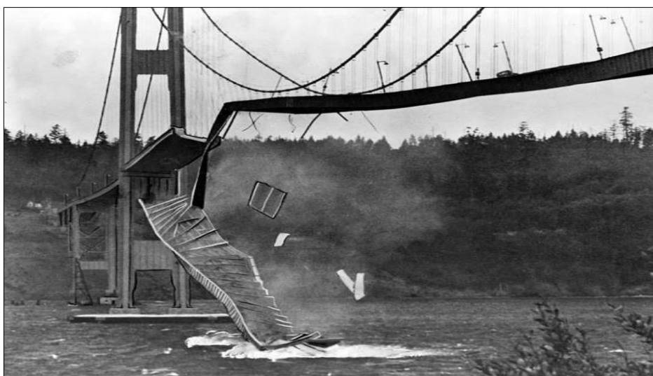
Figura 7 – Ponte Tacoma Narrows em colapso
