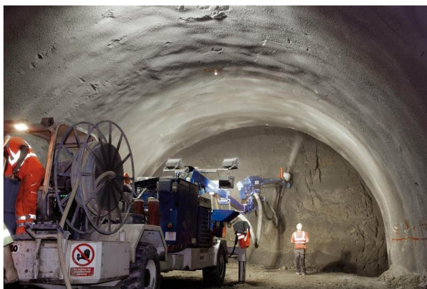
Figura 3 – Suporte de concreto projetado
