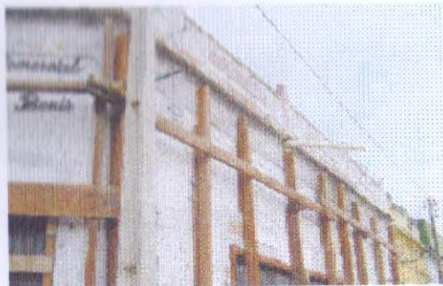
Edifício na rua Tristão Gonçalves com a estrutura danificada devido às obras do Metrofor.
