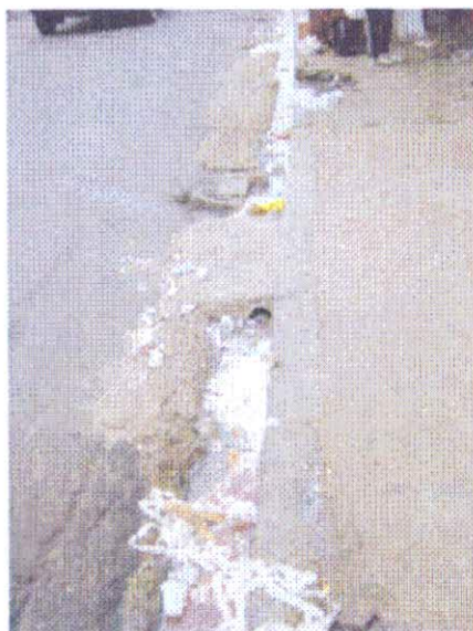
O acúmulo de lixo e a conseqüente obstrução das galerias de água pluviais (rua 24 de Maio)
