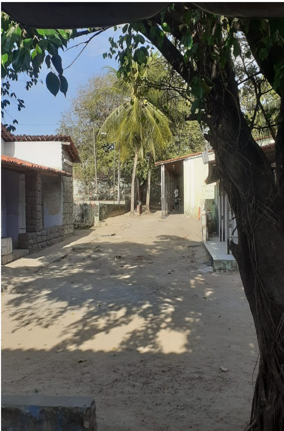
Figura 10 – Precariedade em imagens
