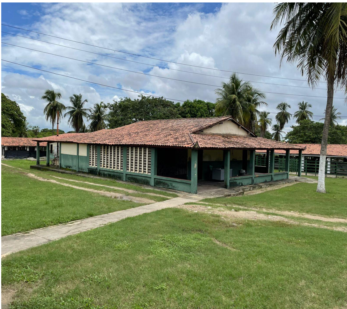
Fotografia 32 – Prédio, que hoje é o tear, onde ficavam as primeiras salas da escola, no ano de 1993
