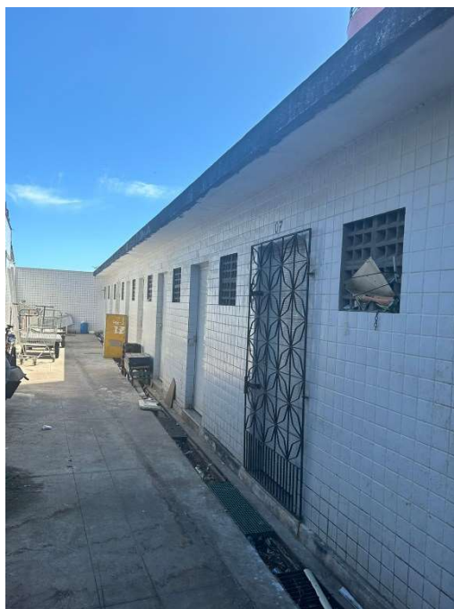
Figura 13 - Salas construídas para os pescadores (2024)
