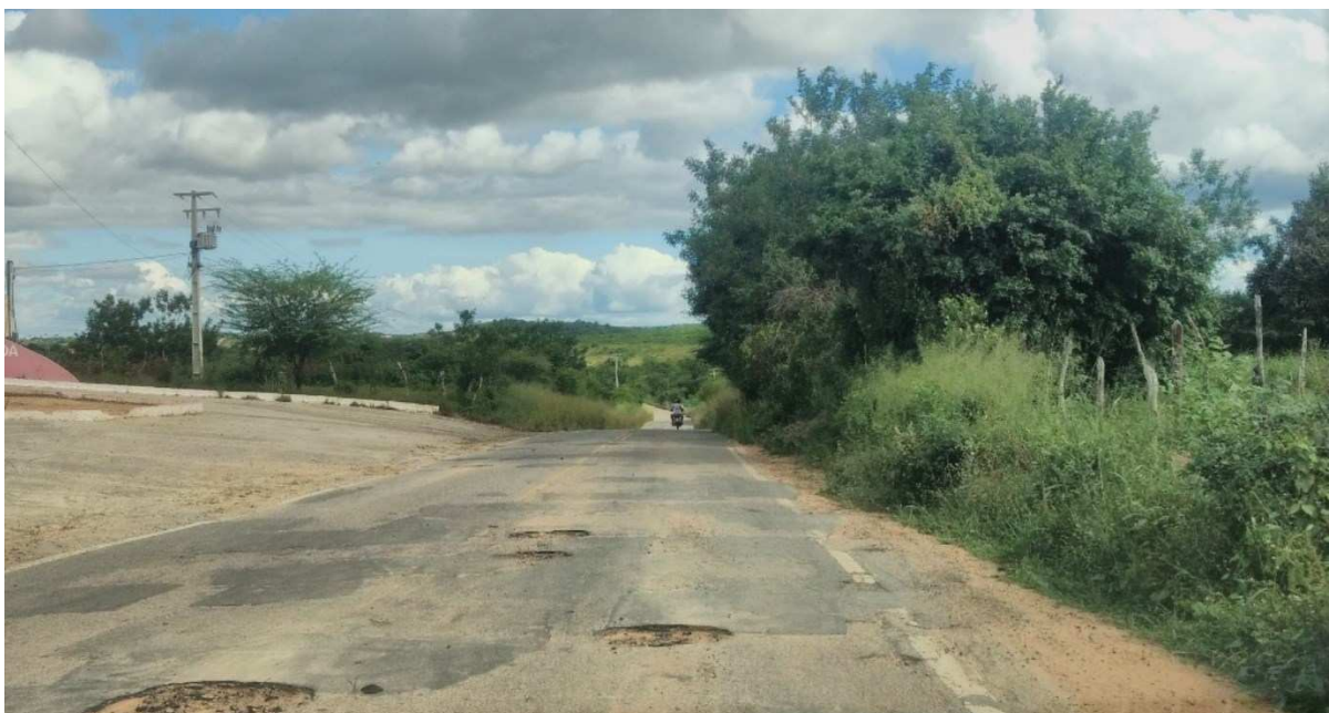
Figura 8 – Desgaste de borda na CE-060, trecho Jardim-Divisa Ceará - Pernambuco
