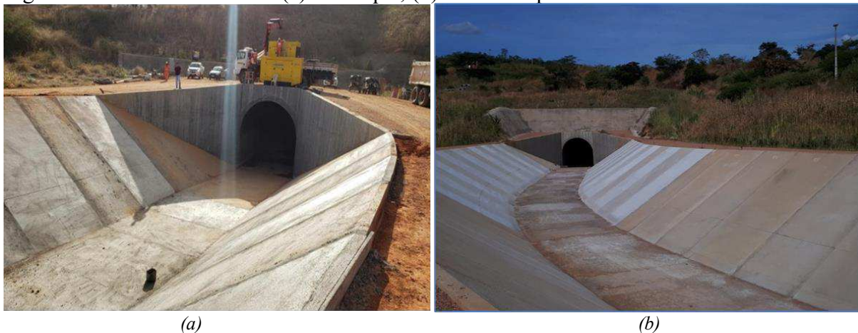
Figura 2.5 – Túnel Boa Vista. (a) Emboque; (b) Desemboque.
