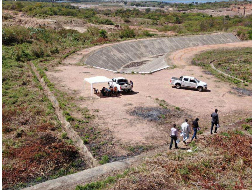
Figura 2.7 – Inspeção no entorno do túnel Boa Vista.
