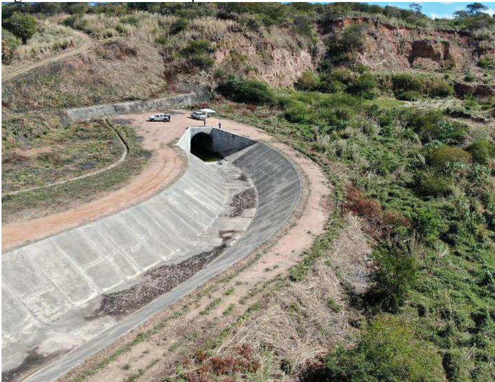
Figura 4.8 – Entorno e emboque do túnel Boa Vista.
