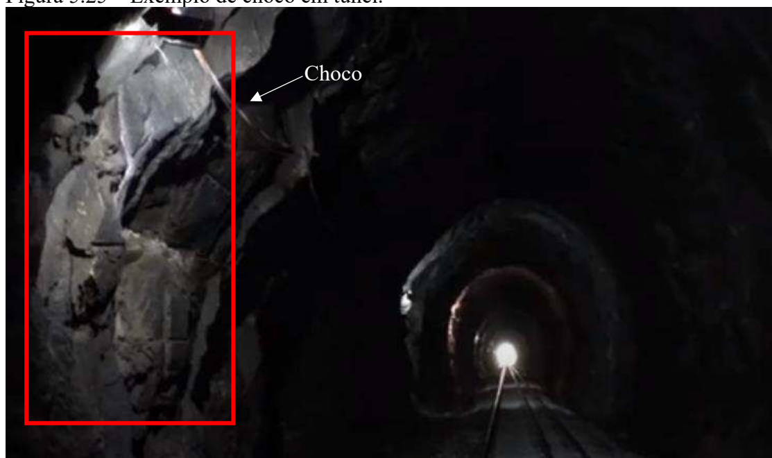
Figura 5.25 – Exemplo de choco em túnel.
