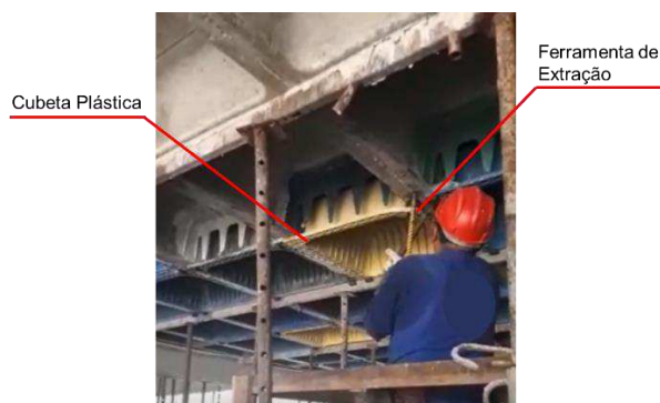
Figura 2 – Extração das formas plásticas
