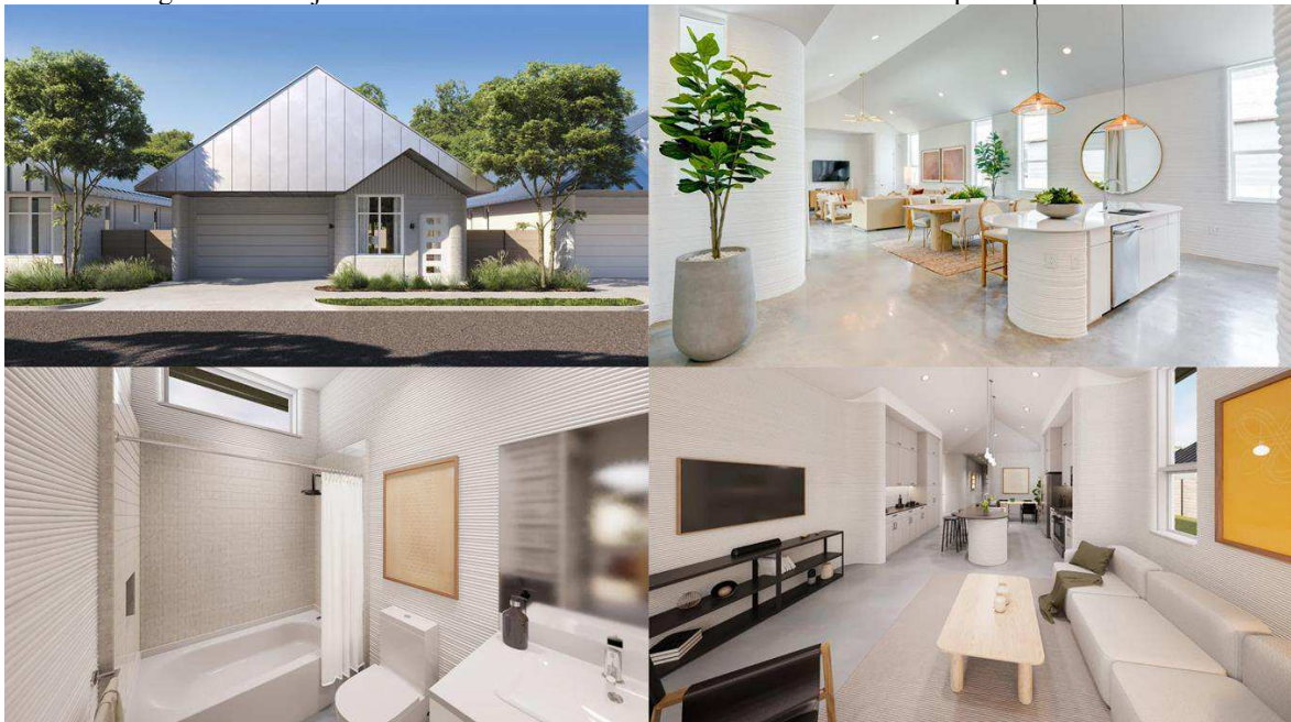
Figura 13 - Projeto Wolf Ranch: o maior bairro do mundo construído por impressão 3D
