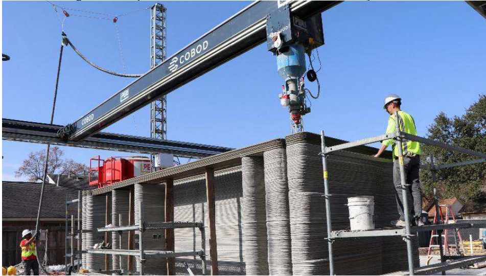
Figura 8 - Impressora 3D à base de extrusão na construção de casa
