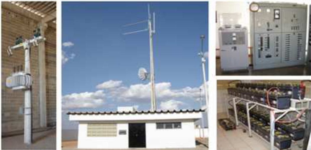
Figura 8 – Componentes de uma Casa de Comando.
