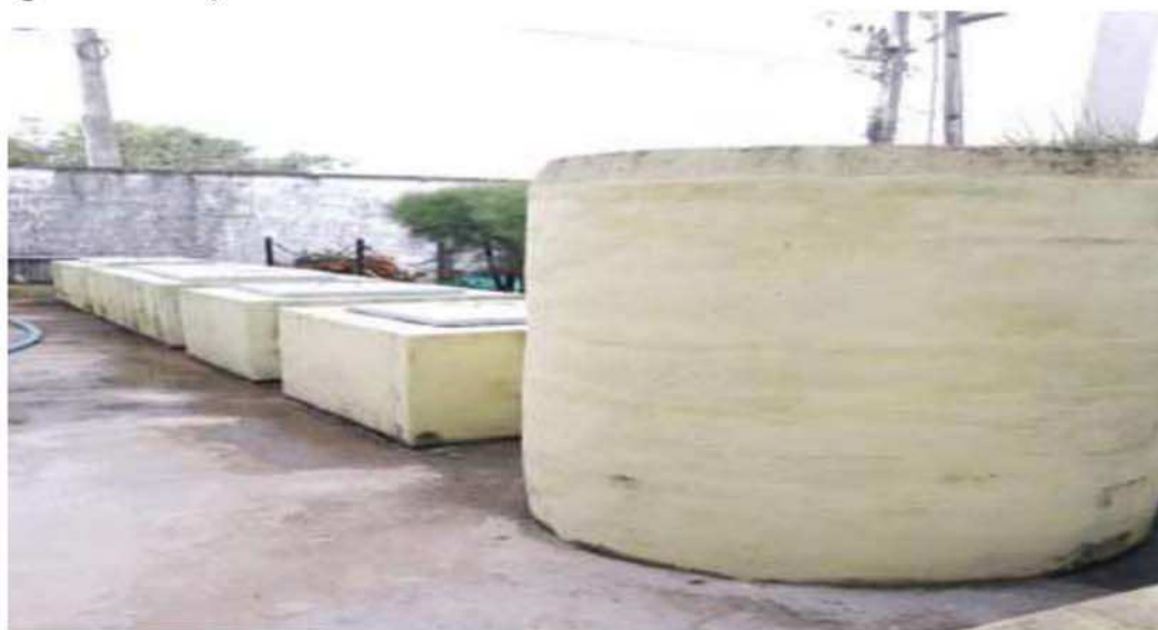
Figura 10: Estação de tratamento de Efluente
