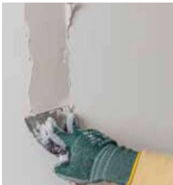
Figura 2 – Tratamento de fissuras
