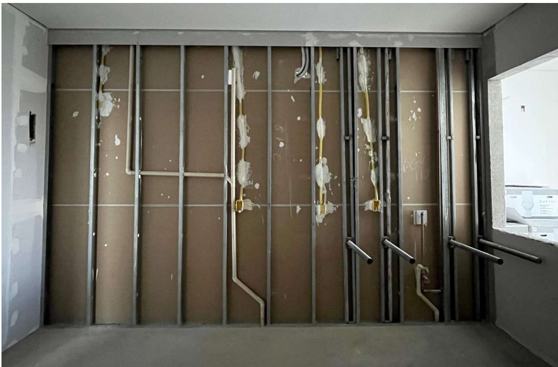
Figura 9 – Estrutura interna das divisórias
