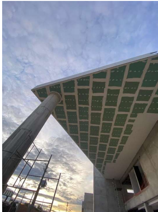
Figura 12 – Execução de forro externo
