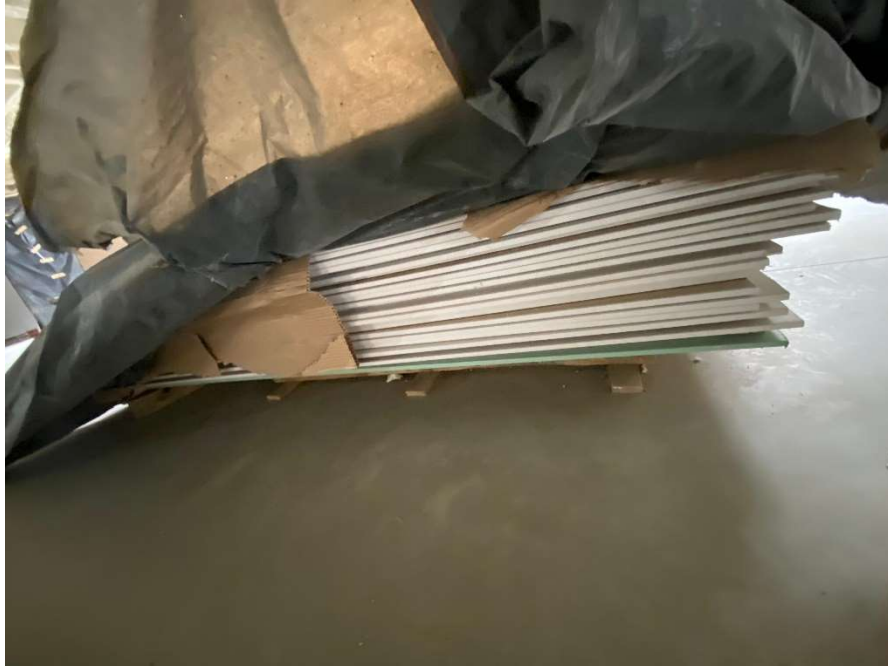
Figura 13 – Armazenamento das placas de gesso acartonado
