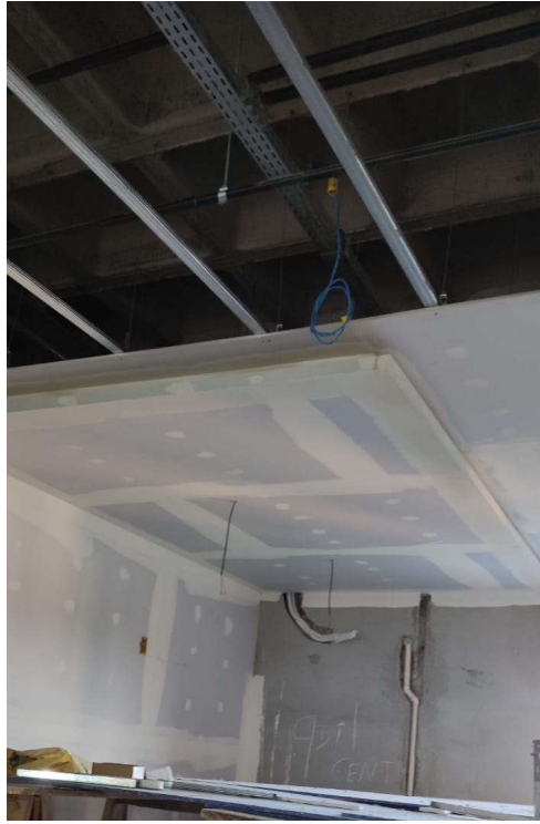
Figura 11 – Execução de forro interno
