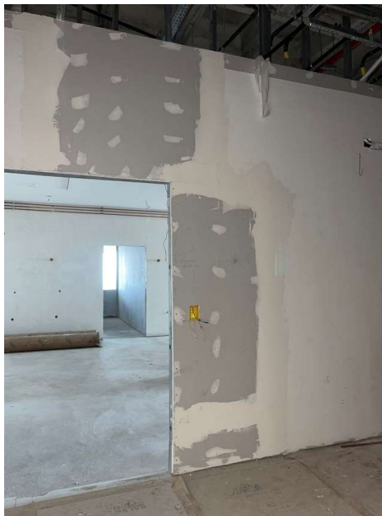
Figura 10 – Chapeamento das divisórias
