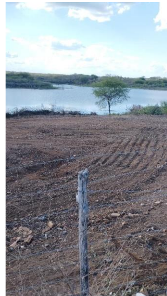
Figura 07 - Rastros do maquinário e amontoado de restos da vegetação retirada da APP.
