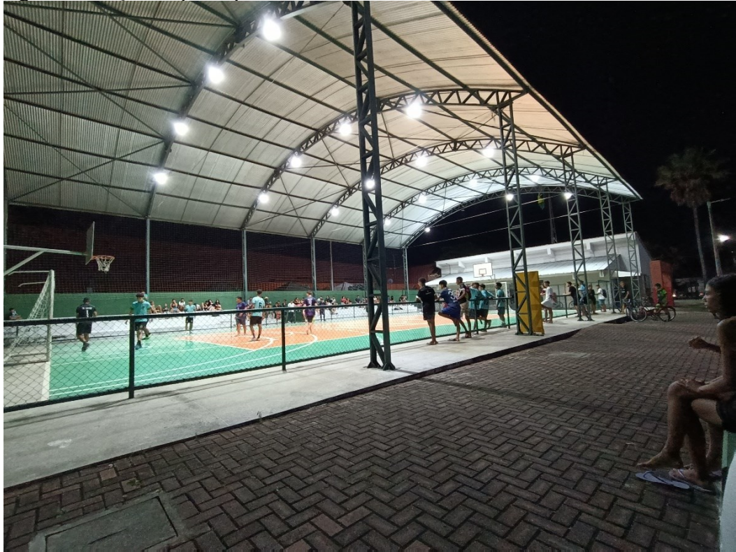
Figura 10 – Quadra poliesportiva coberta
