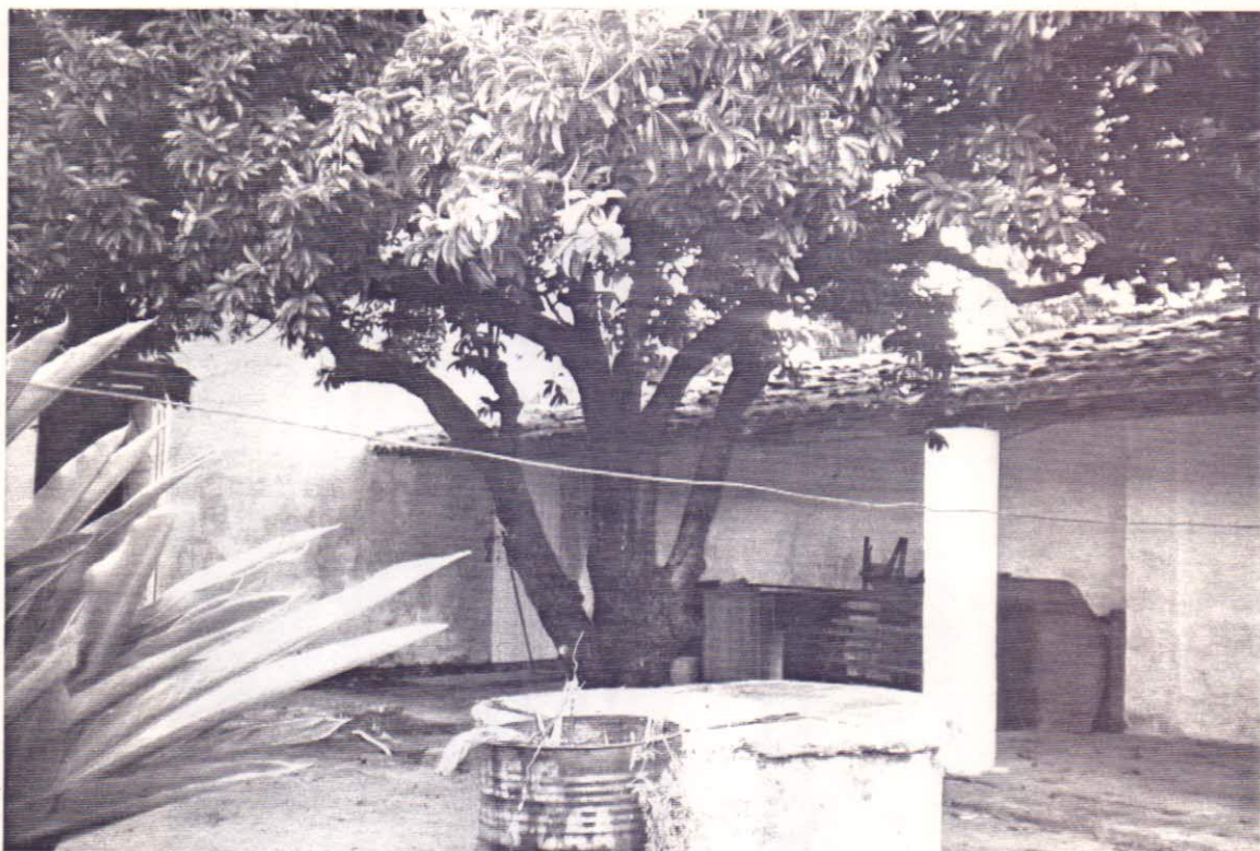
Foto 21 - Tambor de lixo da REU da AV. da Universidade, 2142. Local inadequado, vizinho a cisterna, de difícil acesso a partir da rua.
