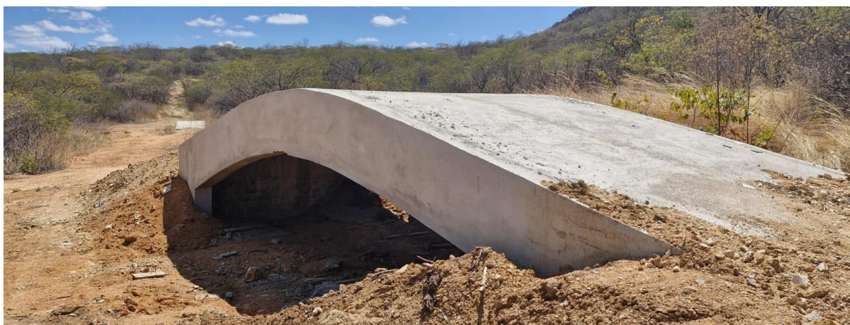
Figuras 24 – Foto da obra de infraestrutura em andamento, rampa de acessibilidade
