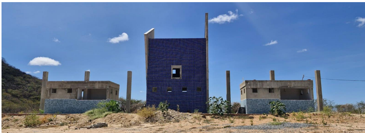
Figuras 23 – Foto da obra de infraestrutura em andamento, quiosques e banheiros
