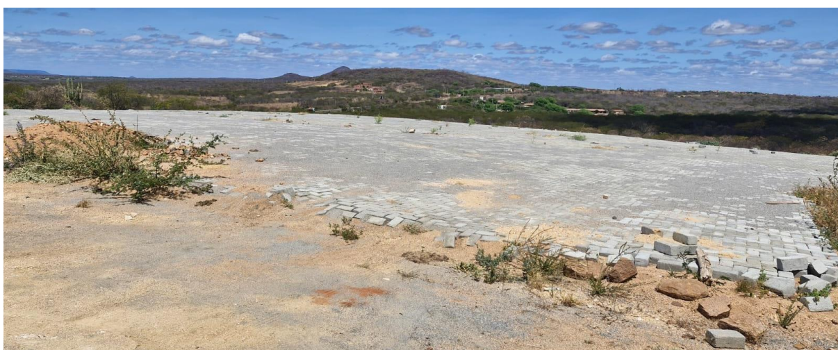
Figura 21 – Foto da obra de infraestrutura em andamento, estacionamento
