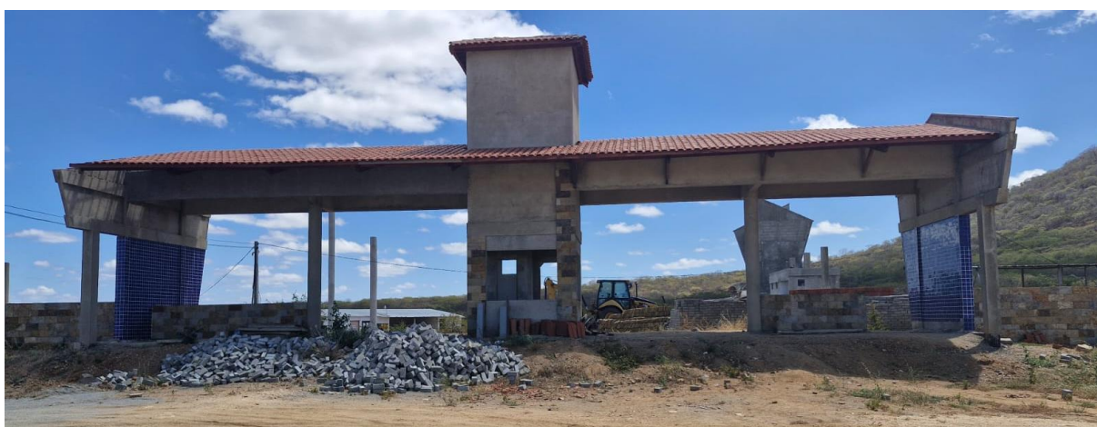
Figuras 22 – Foto da obra de infraestrutura em andamento, portal de entrada e guarita
