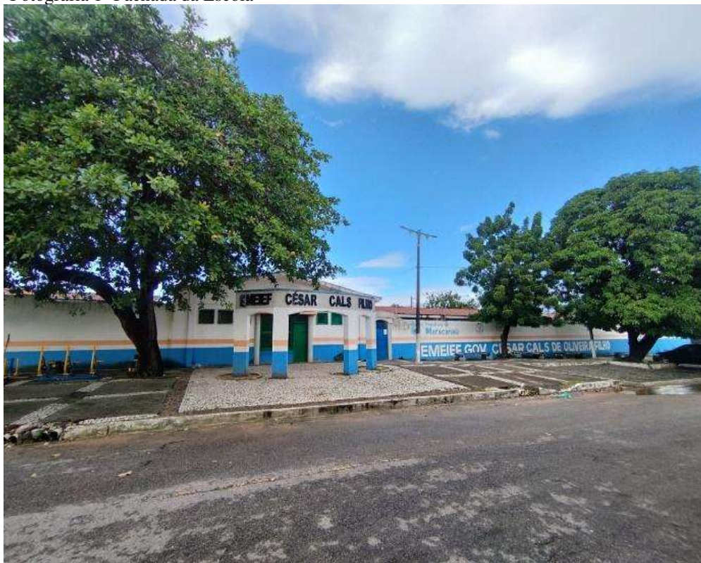
Fotografia 1- Fachada da Escola
