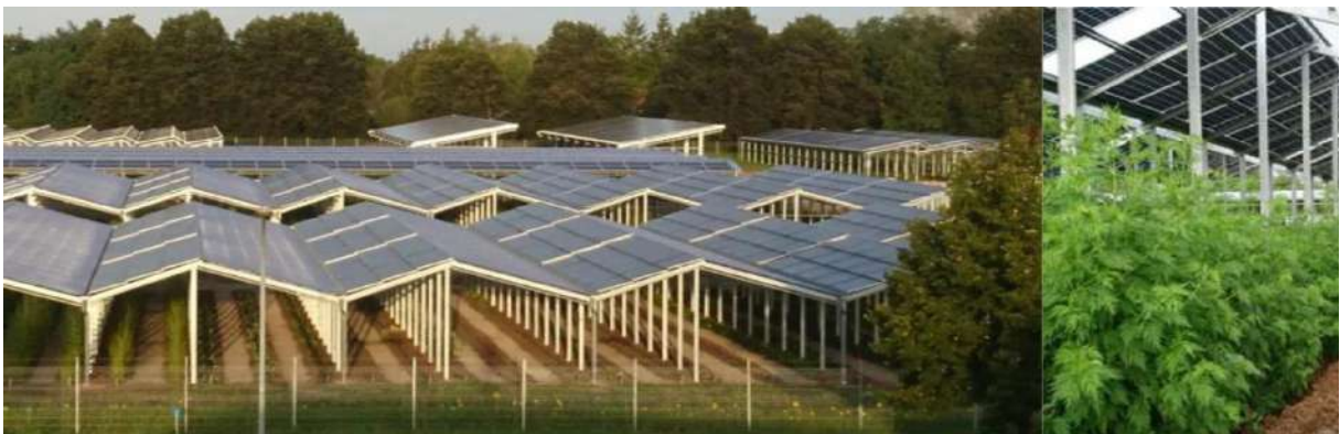
Figura 37 – O modelo “agrivoltaico” combina sistemas fotovoltaicos e a produção de alimentos (agricultura).
